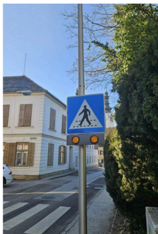
Schutzweg mit Blinkanlage im Einsatz · Anwendungsbeispiel (schematisch)
