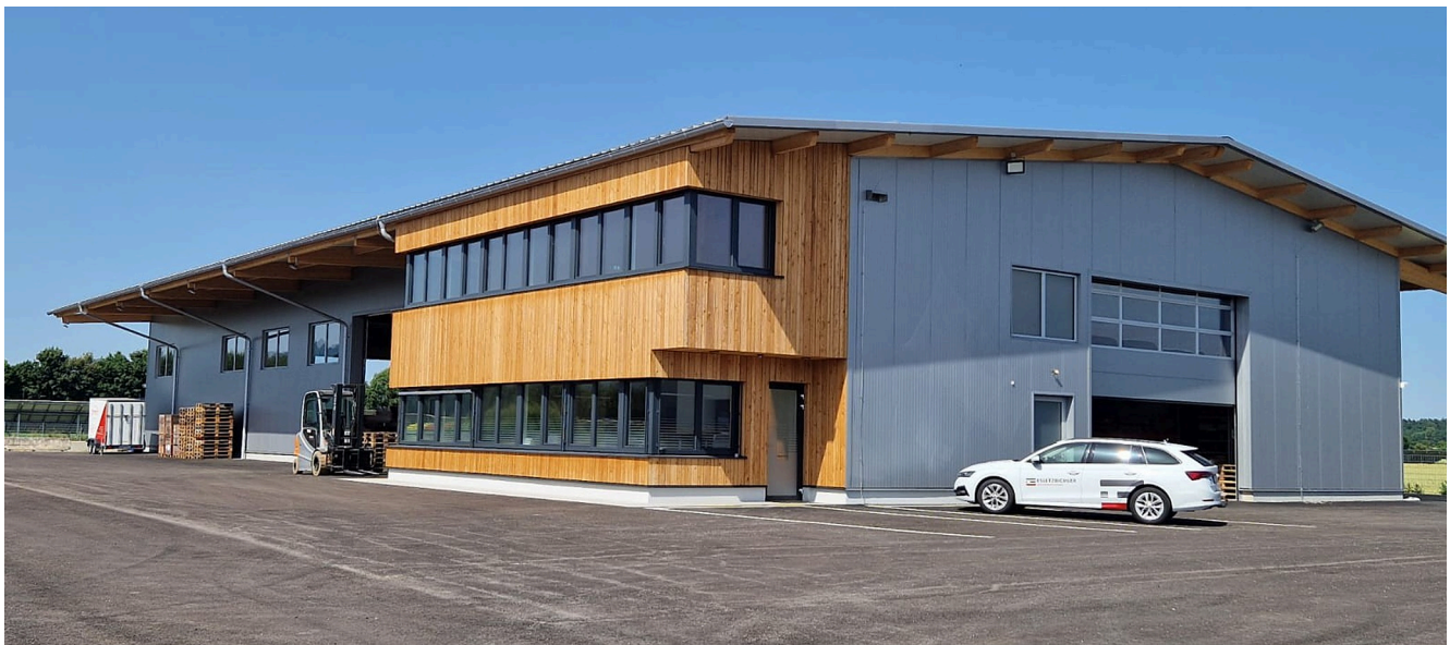
Unsere neu errichtete Lagerhalle
