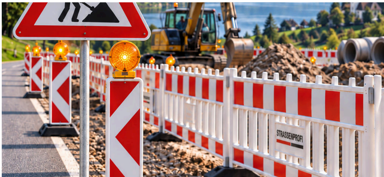
Absicherung einer Straßenbaustelle
